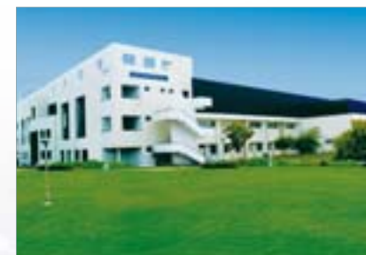
Chennai plant(インド)
